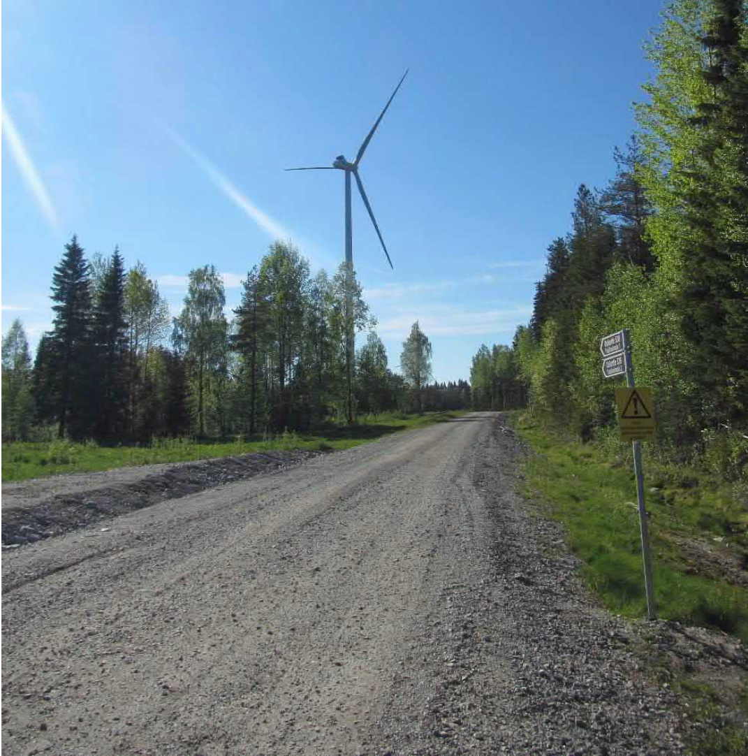
Kuva 2-3. Esimerkki tuulipuiston rakennus- ja huoltotiestä. © AFRY Finland Oy.
